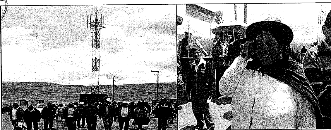
Estación base satelital de telefonía celular de los Proyectos de Mejoramiento y Ampliación de los servicios de Comunicación en las Zonas Rurales del Dpto.
