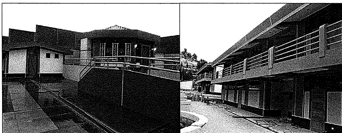
MEJORAMIENTO DE LOS SERVICIOS EDUCATIVOS DE LA I.E INICIAL N° 736 DEL CENTRO POBLADO DE YANAOCO - DISTRITO DE ACORIA y MEJORAMIENTO DE LA CAPACIDAD PRODUCTORA DE SERVICIOS EDUCATIVOS DE LA I. E. DE NIVEL PRIMARIO N 36048 DEL, DISTRITO DE LARIA
